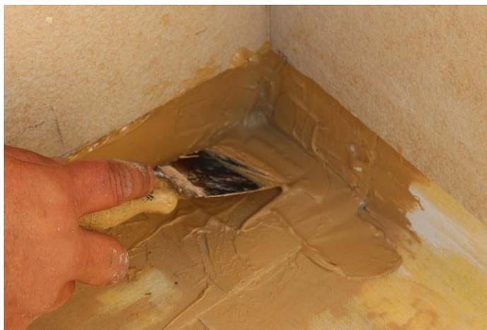
1. Depois de instalada a lamina **DRY80/DRY120 POOL**, aplicar adesivo **SEALPLUS** sobre a zona do canto.
