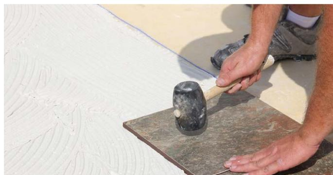
**6.** Colocar o pavimento diretamente com cimento cola de classe C2 e fixar o rodapé. Trabalho concluído de forma rápida, fácil e com garantia de qualidade.
