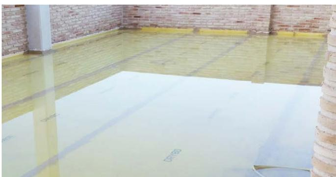
**5. OPCIONAL:** quando a instalação estiver concluída, com um tempo de espera de 48 horas, pode realizar-se um teste de estanqueidade preciso.
