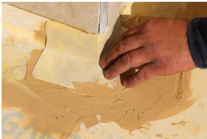
3. Depois de instalada a lamina **DRY80/DRY120 POOL**, aplicar adesivo **SEALPLUS** sobre a zona da esquina.
