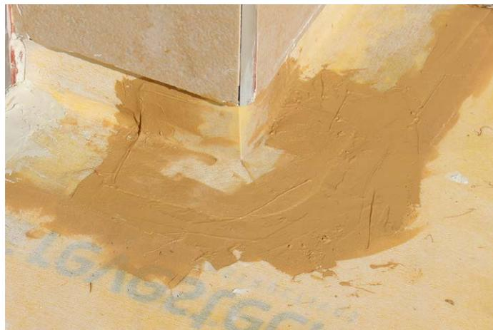
4. Colocar a peça **DRY80 CORNER OUT** e voltar a aplicar adesivo **SEALPLUS** sobre a peça, criando uma selagem dupla.
