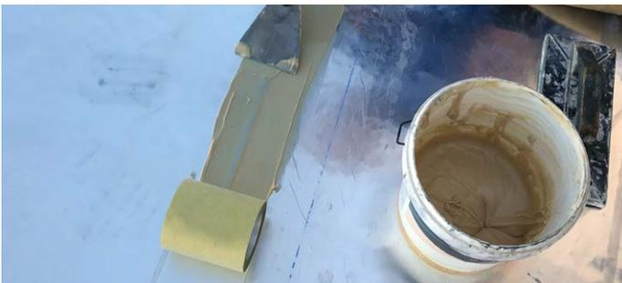
5. Selar as juntas entre laminas com **ALU BANDA DRY 10**, colando-a com adesivo **BIPLUS**.
