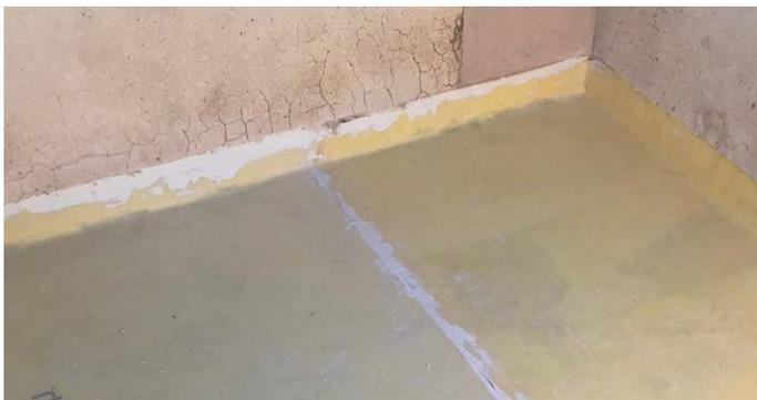
**3.** As laminas são encostadas e, em seguida, selam-se as juntas com banda **DRY50 BANDA 13**, colada com adesivo especial **SEALPLUS**.
