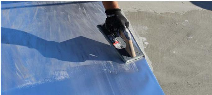
3. Pressionar com força a lamina sobre o suporte com ajuda da talocha, certificando-se de remover todas as possíveis bolhas de ar que tenham sido geradas. **CUIDADO:** uma vez instalada a lamina, temos de garantir que está totalmente colada ao suporte.
