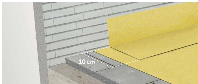
Colocar a banda perimétrica **DRY80 BANDA** respeitando a altura do rodapé e deixando pelo menos 10 cm de sobreposição sobre a lamina.
