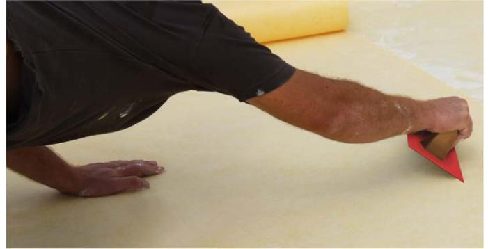
**2.** Pressionar com força a lamina sobre o suporte com ajuda da talocha, certificando-se de que elimina todas as possíveis bolhas de ar que tenham sido geradas.
