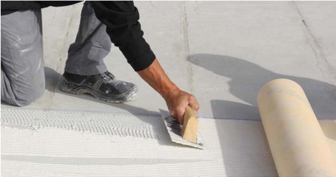
**1.** Verificar a estabilidade do suporte e limpar a superfície. Em seguida, aplicar cimento cola de classe C2 com uma talocha dentada. Aplicar o adesivo em pequenas secções para evitar a secagem. Não se deve, em caso algum, instalar a lamina sobre um cimento cola semicurado. **NOTA:** em renovações, aplique o cimento cola diretamente sobre o pavimento antigo.
