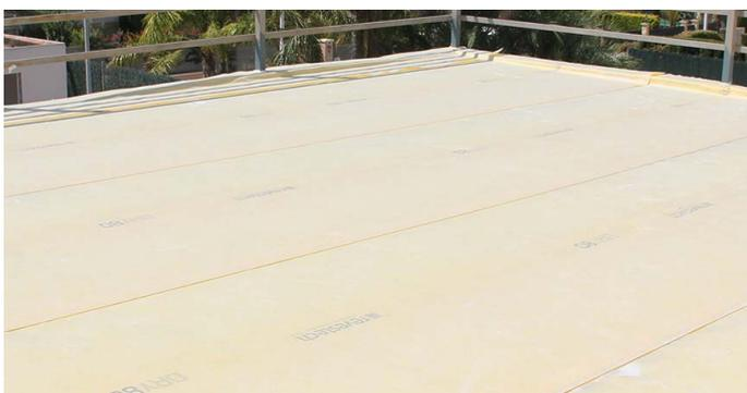
**3.** Instalar as laminas sempre a favor da inclinação, a partir do sumidouro para cima. Deixar uma sobreposição mínima entre laminas de 10 cm.
