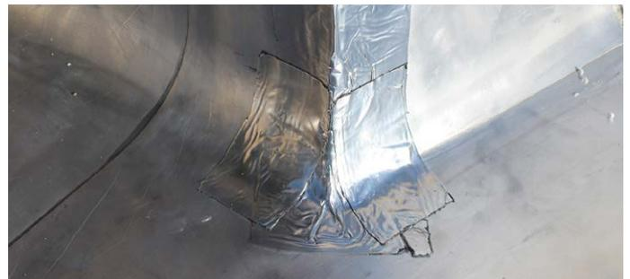
6. Em uniões especiais, como cantos e esquinas, utilizamos a banda adesiva **ALU BANDA BUTILO 10** para um acabamento perfeito. **NOTA:** não instalar **ALU BANDA BUTILO 10** sobre a lamina húmida. Antes de colocar **ALU BANDA BUTILO 10**, limpar bem o local onde vai ser colada.
