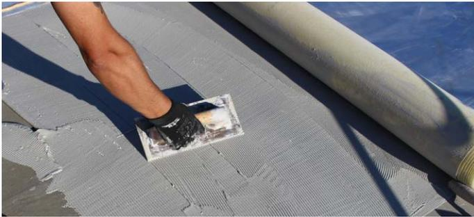
1. Verificar a estabilidade do suporte e limpar a superfície. Em seguida, aplicar cimento cola de classe C2 com uma talocha dentada. Aplicar o adesivo em pequenas secções para evitar a secagem. **NOTA:** em renovações, aplique o cimento cola diretamente sobre o pavimento antigo.
