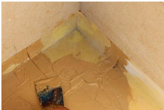
2. Colocar a peça **DRY80 CORNER IN** e voltar a aplicar adesivo **SEALPLUS** sobre a peça, criando uma selagem dupla.
